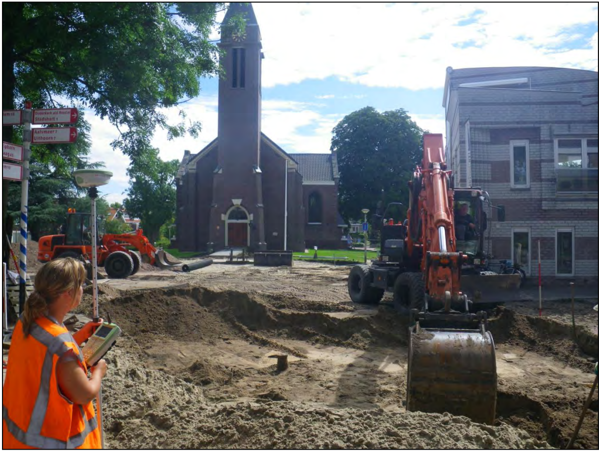
Figuur 1: Sfeerfoto van de werkzaamheden.
